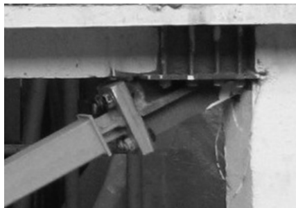
图 3 支撑与框架连接
